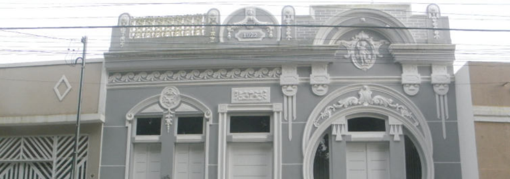
Imagem 14: Residência na praça da Matriz, datada de 1922 (foto: João Paulo Araújo de Carvalho, 2020)
